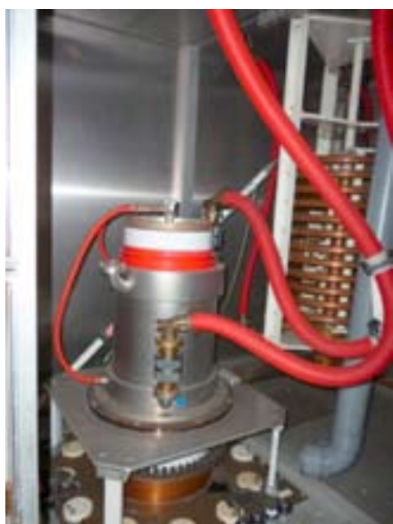
Tube en céramique de 1 MW (1994) Une des selfs du coupleur d'antennes Tubes push-pull BF 200 kW (~1970)
