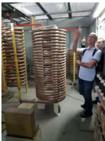
Tube en céramique de 1 MW (1994) Une des selfs du coupleur d'antennes Tubes push-pull BF 200 kW (~1970)
