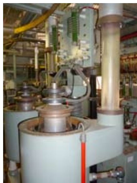
Tube en céramique de 1 MW (1994) Une des selfs du coupleur d'antennes Tubes push-pull BF 200 kW (~1970)
